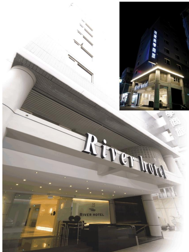
外觀整修後照片
